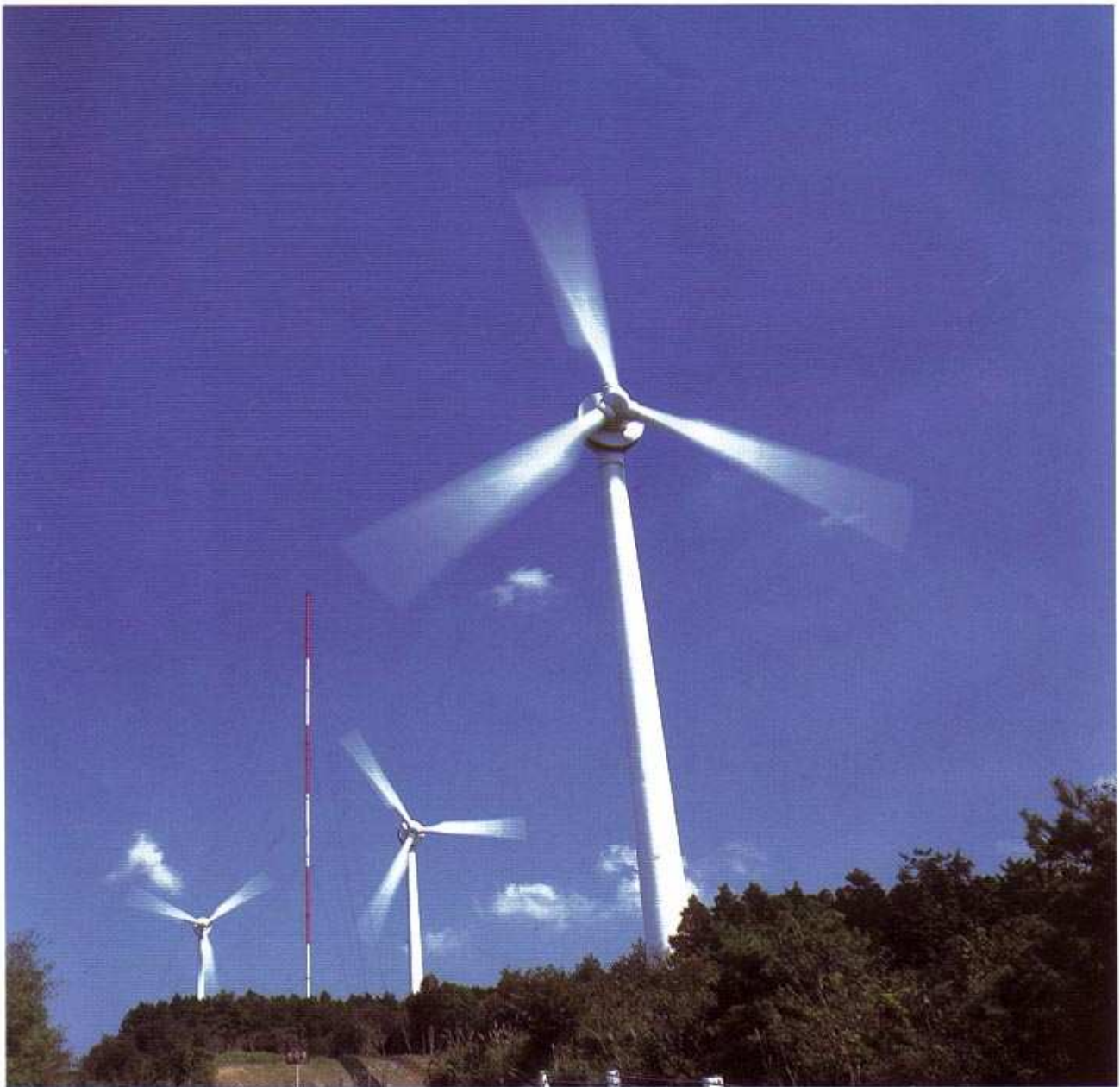
「久居榊原風力発電施設」(久居市)
