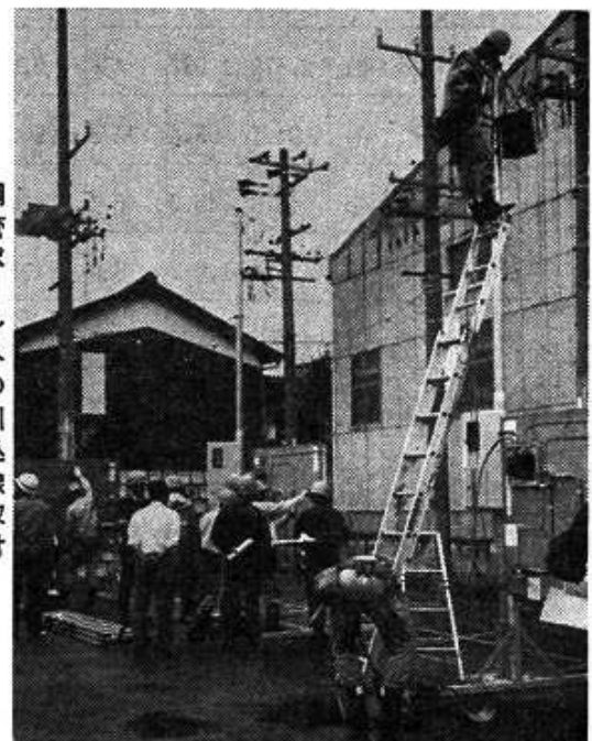
鋼管ポールへの引込線取付
