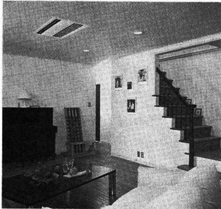
ビルトインエアコン天井内設置例
