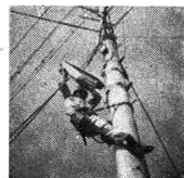
街灯の点検作業
