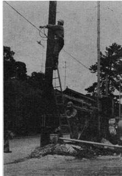
昇柱点検も確実に
