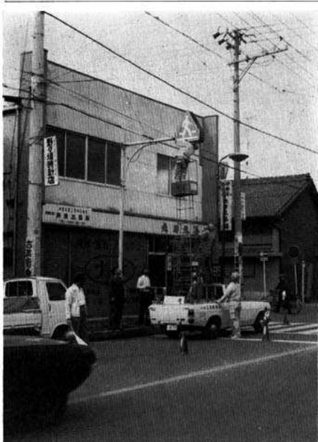
横断歩道灯の修理(鈴鹿)
