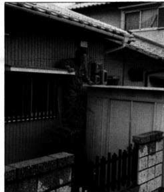
新築後、小屋が設置されはしごをかけ、屋根にあがらなければ検針ができない。住宅団地等で新設後1、2年でブロック塀、物置等の設置で検針困難になる例が多い。
