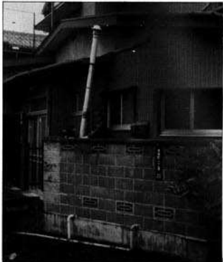
ブロック併があから設置されトイレの通気管へ抱きつき鏡でやっとな検針する。右側の2台は、川からブロック塀によじ登り検針する。
