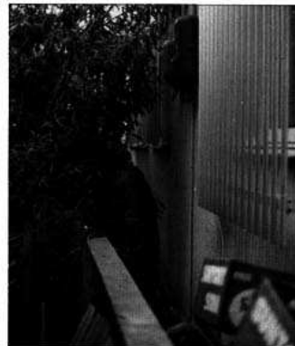
家屋側面に計器があり、隣家との間が狭く、足場にドブがあって後へさがれず、検針困難(計器位置2.2m)
